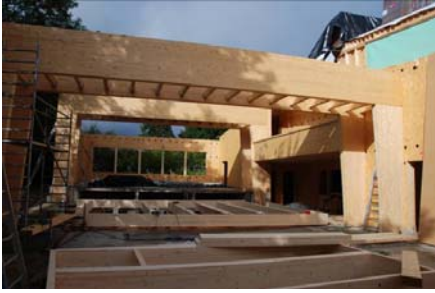
Montage des Daches über dem Saal ...
