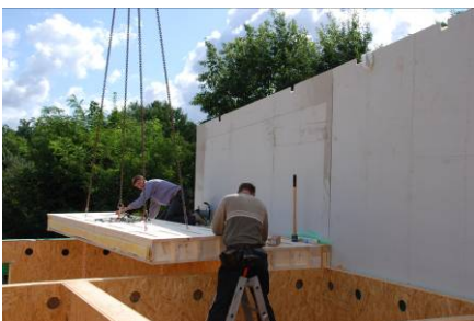
Verlegen der Deckenelemente
