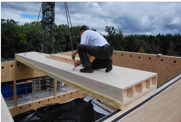
Verlegen der Dachelemente
