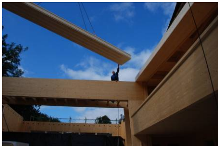
Montage des Daches über dem Saal
